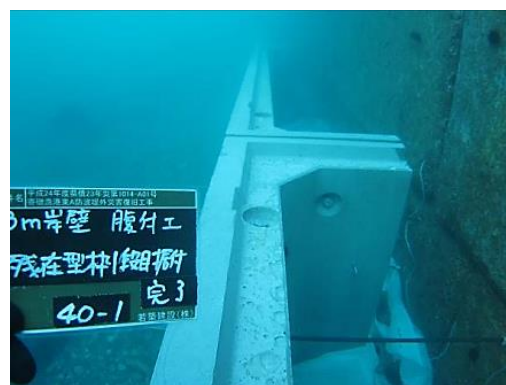
写真 1-6 残置型枠の据付状況(例)
