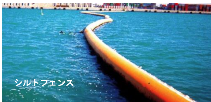
写真 4-1 シルトフェンスの例
