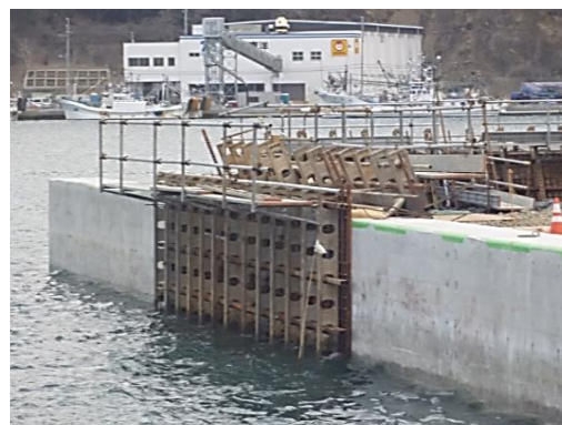
写真 1-1 従来工法の施工状況
