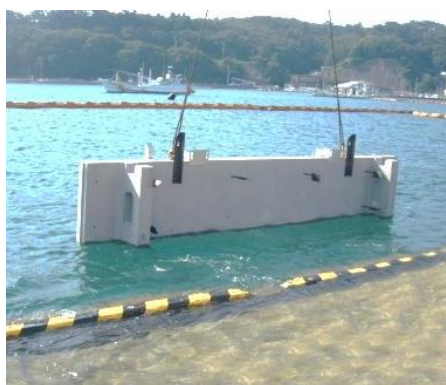
写真 1-5 残置型枠の吊り込み状況(例)
