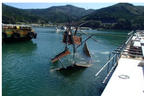
写真 1-3 鋼製型枠の被災(例)
