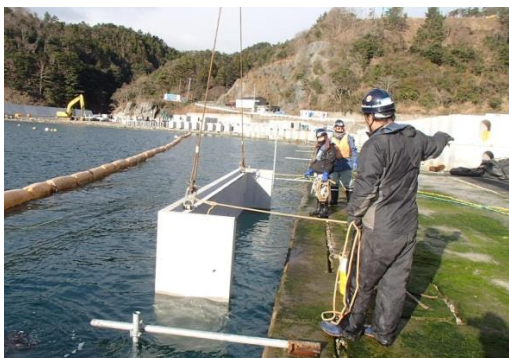
写真 2-1 残置型枠
