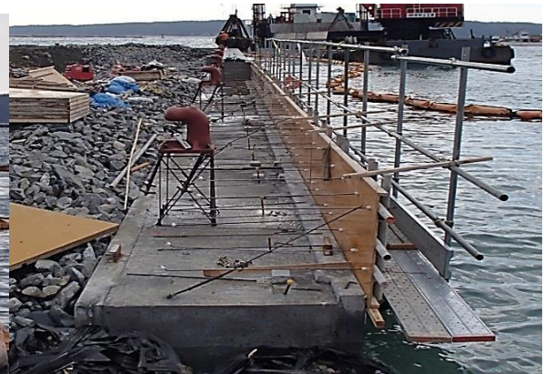
写真 4-8 上部工の施工例
