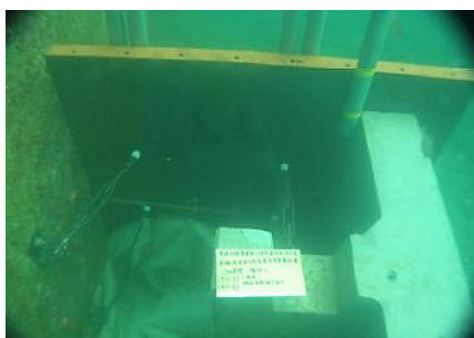
写真 4-4 端部処理の例（鋼製型枠）
