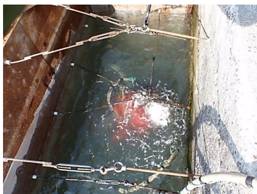
写真 1-2 鋼製型枠内の潜水作業(例)
