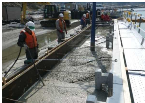
写真 2-2 水中コンクリート
