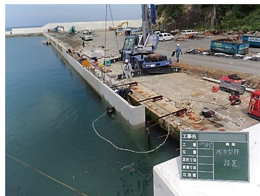
写真 1-4 本工法の施工状況
