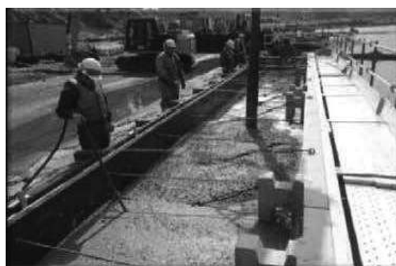
写真-6 実施状況(水中コン打設)
