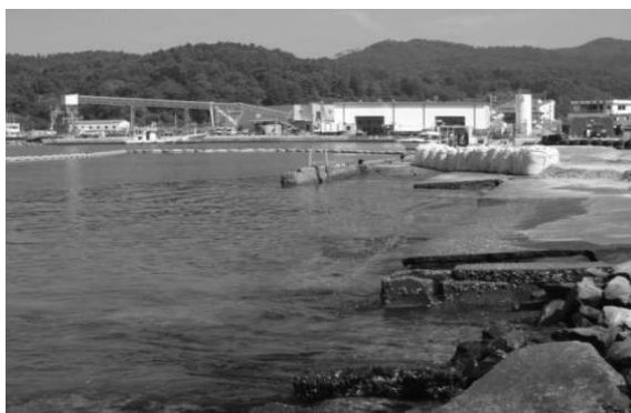
写真-2 被災状況
