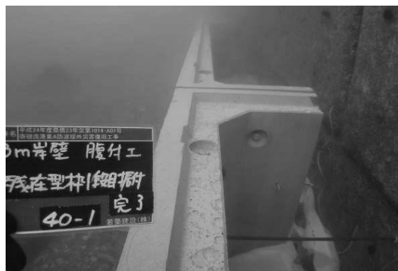
写真-5 実施状況(基礎部)
