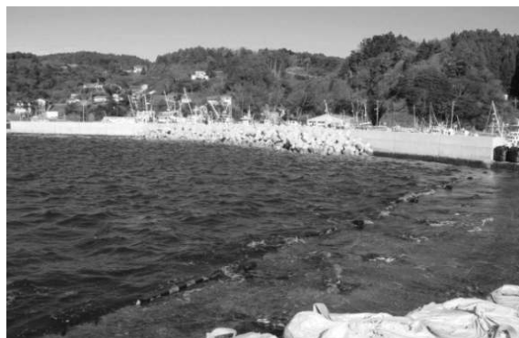
写真-1 被災状況
