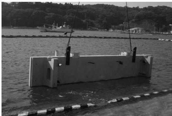
写真-3 実施状況(PCa 据付)
