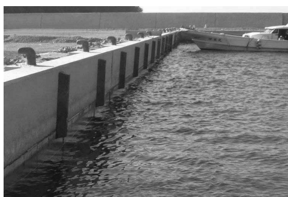
写真-8 実施状況(工事完了)
