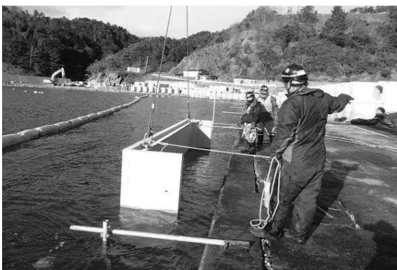
写真-4 実施状況(PCa 据付)
