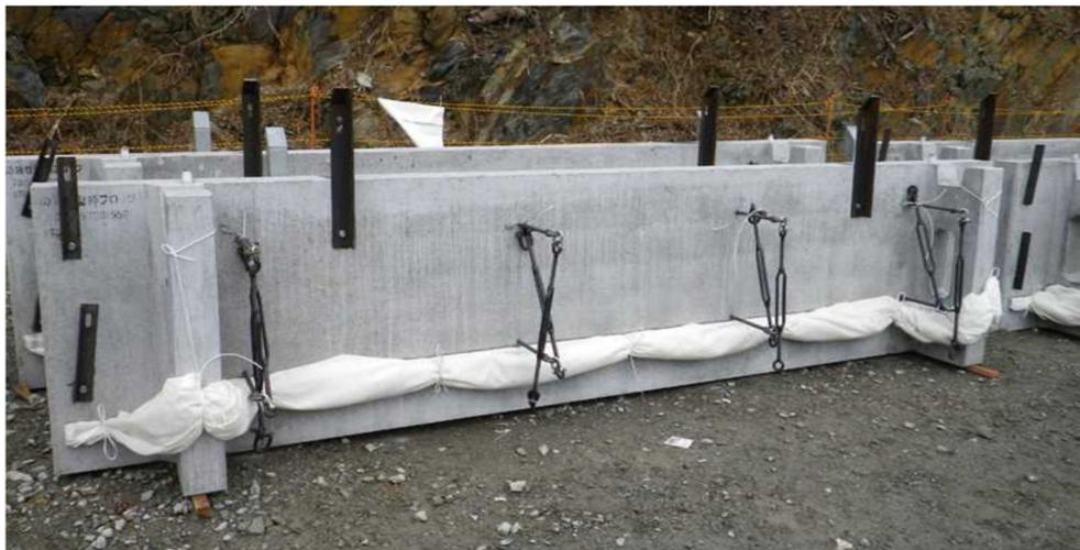
写真 4-2 陸上で残置型枠に漏えい防止シートを固定した例
