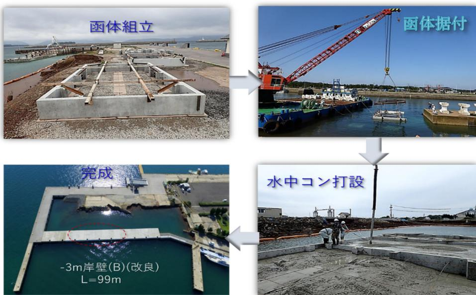
図 4-3 施工概要 (新設工部の例)
