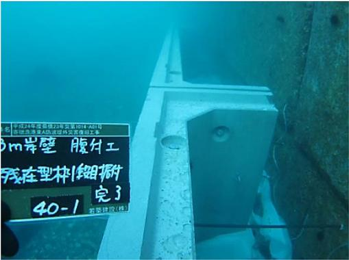
写真 1-6 残置型枠の据付状況(例)
