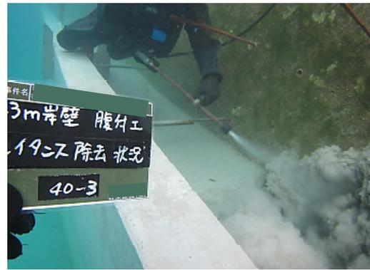
写真 2-4 レイタンスの機械除去 (例)
