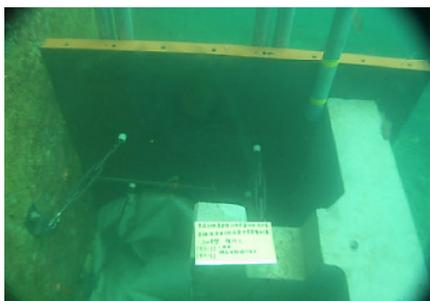
写真 4-4 端部処理の例 (鋼製型枠)
