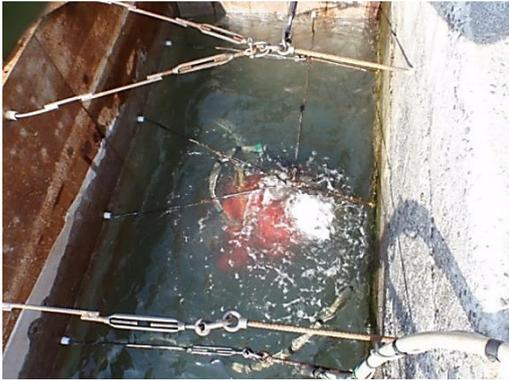
写真 1-2 鋼製型枠内の潜水作業(例)
