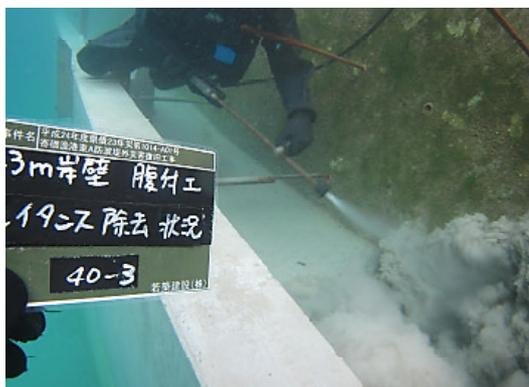
写真 4-5 レイタンス除去作業の例
