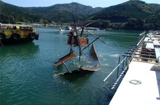
写真 1-3 鋼製型枠の被災(例)
