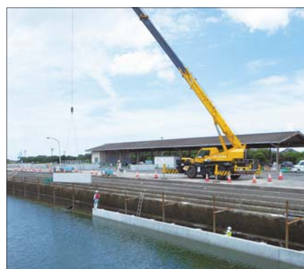
3. 残置型枠の水中布設
