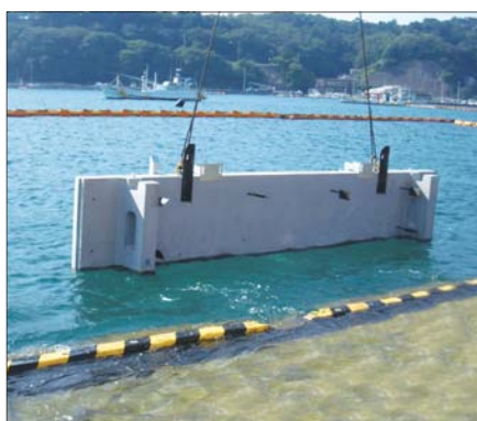
2. 残置型枠吊り状況
