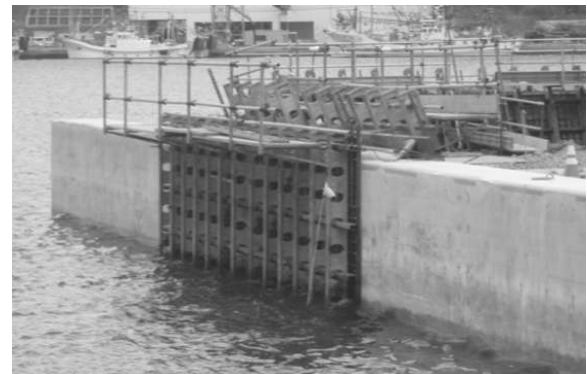
写真-4 施工状況
