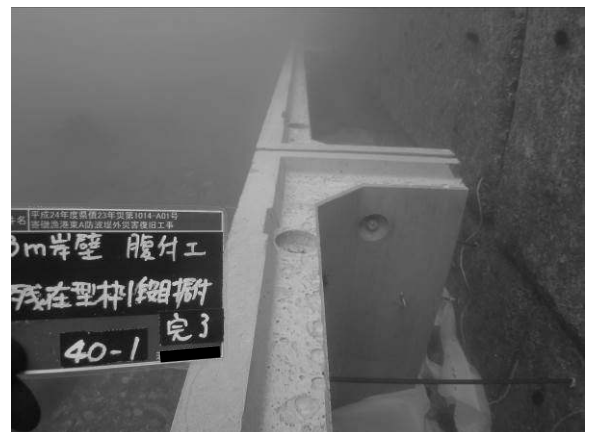
写真-3 施工状況(基礎部)
