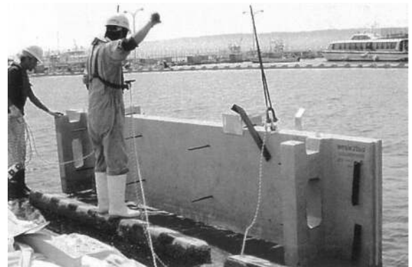
写真-2 残置型枠外観
