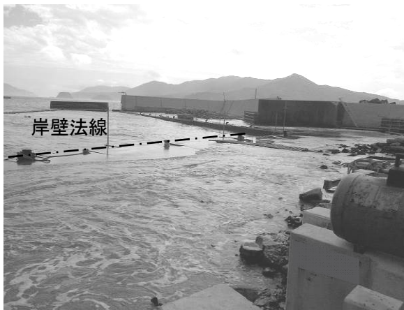
写真-6 物揚場の冠水状況
