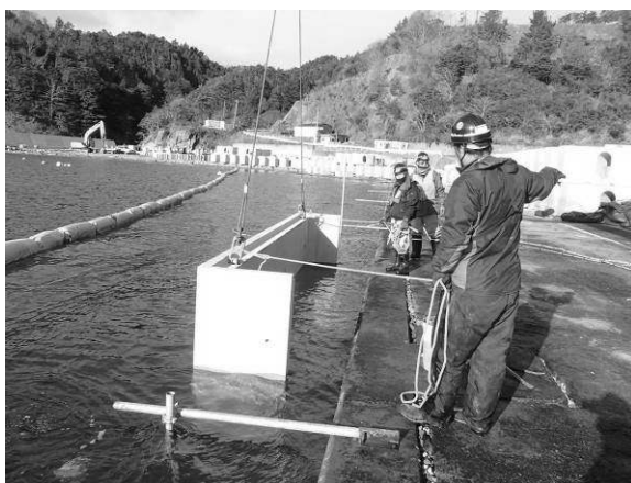
写真-1 残置型枠外観
