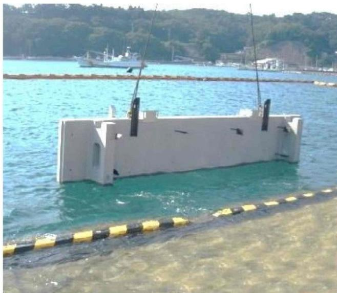
写真 1-5 残置型枠の吊り込み状況(例)
